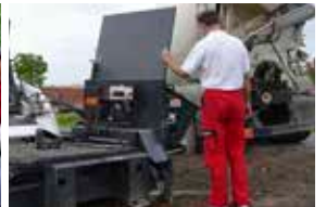
Pompe à béton P. 150
