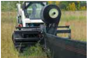
Poseur de clôture à sédiments P. 151
